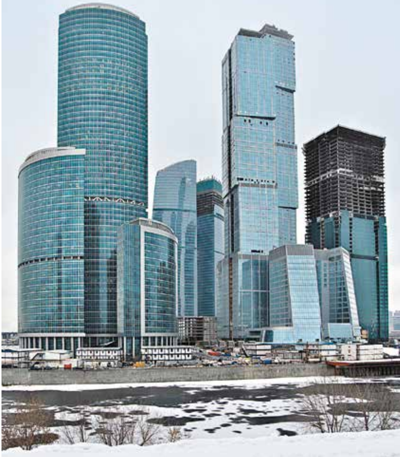
Башня «Федерация» Москва-Сити
